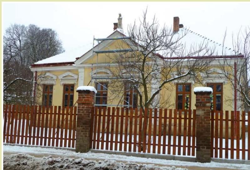
Projekt Pod jednou střechou, oprava fary Domanín.
