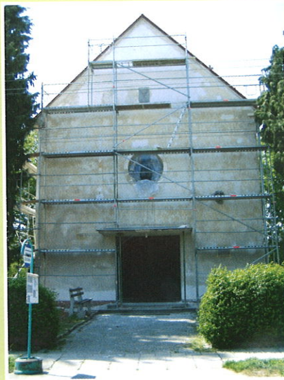
Oprava Sboru J. A. Komenského ve Bzenci.
