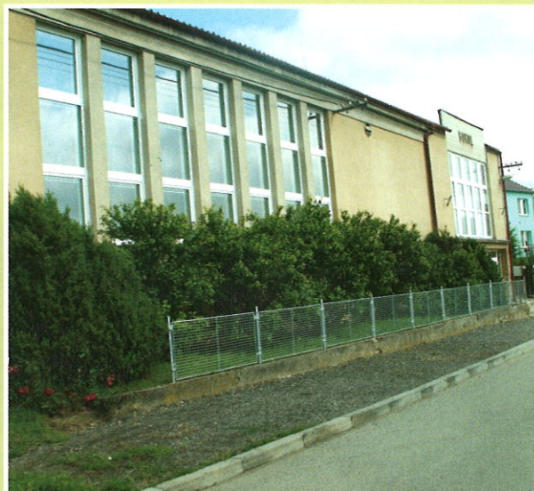
Výměna oken sokolovny v Žeravicích.
